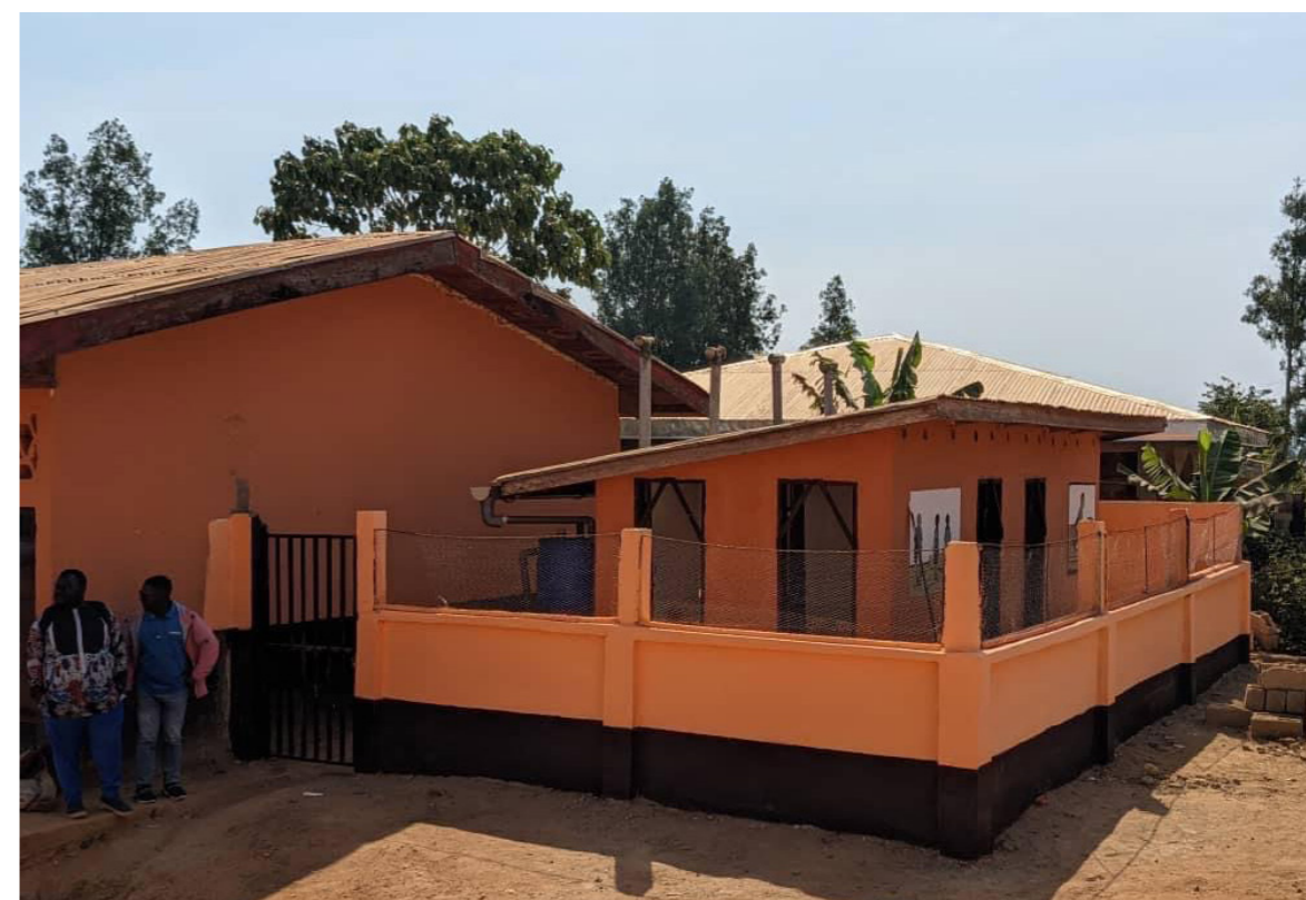
Rénovation des latrines de l'école Ste Raïssa
